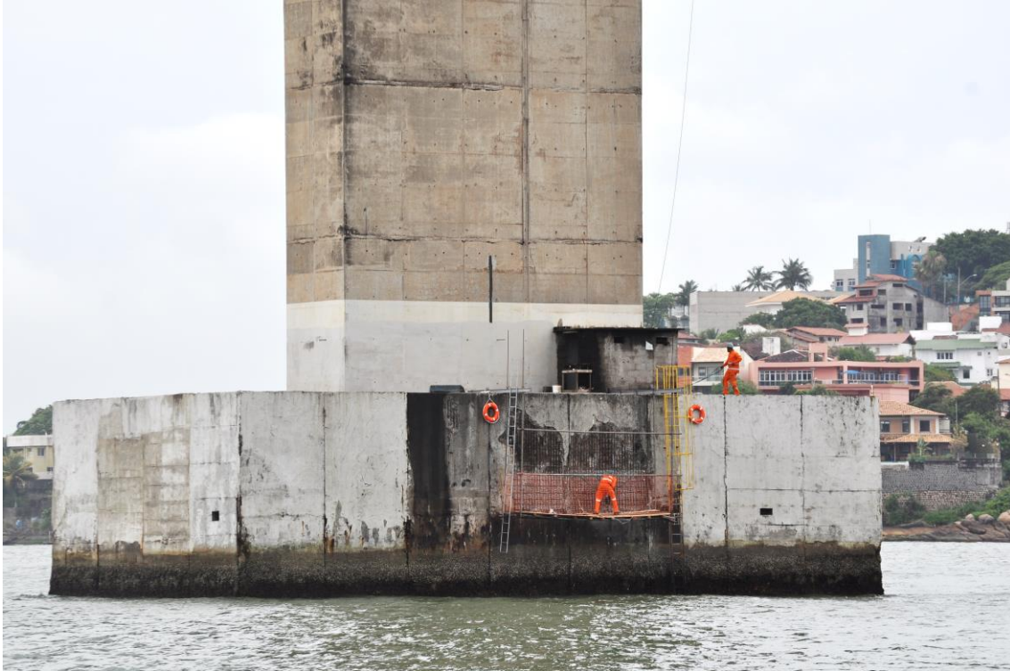
Figura 5 – Evidência de manutenção periódica, garantindo o prolongamento da vida útil da estrutura
