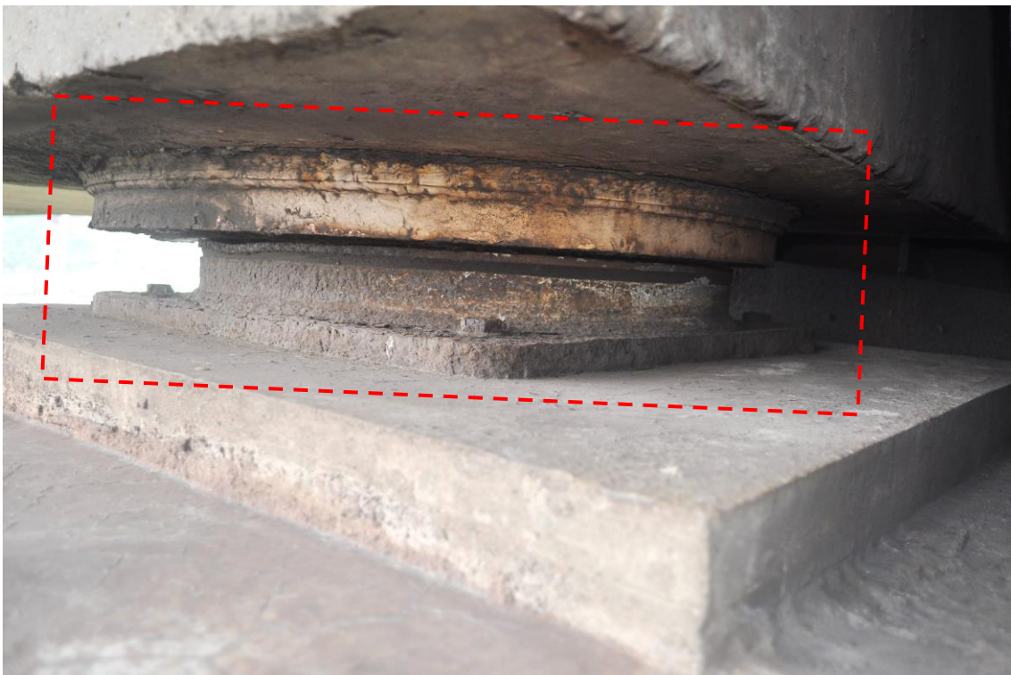
Figura 12 - Aparelhos de apoio com sinais de funcionamento normal
