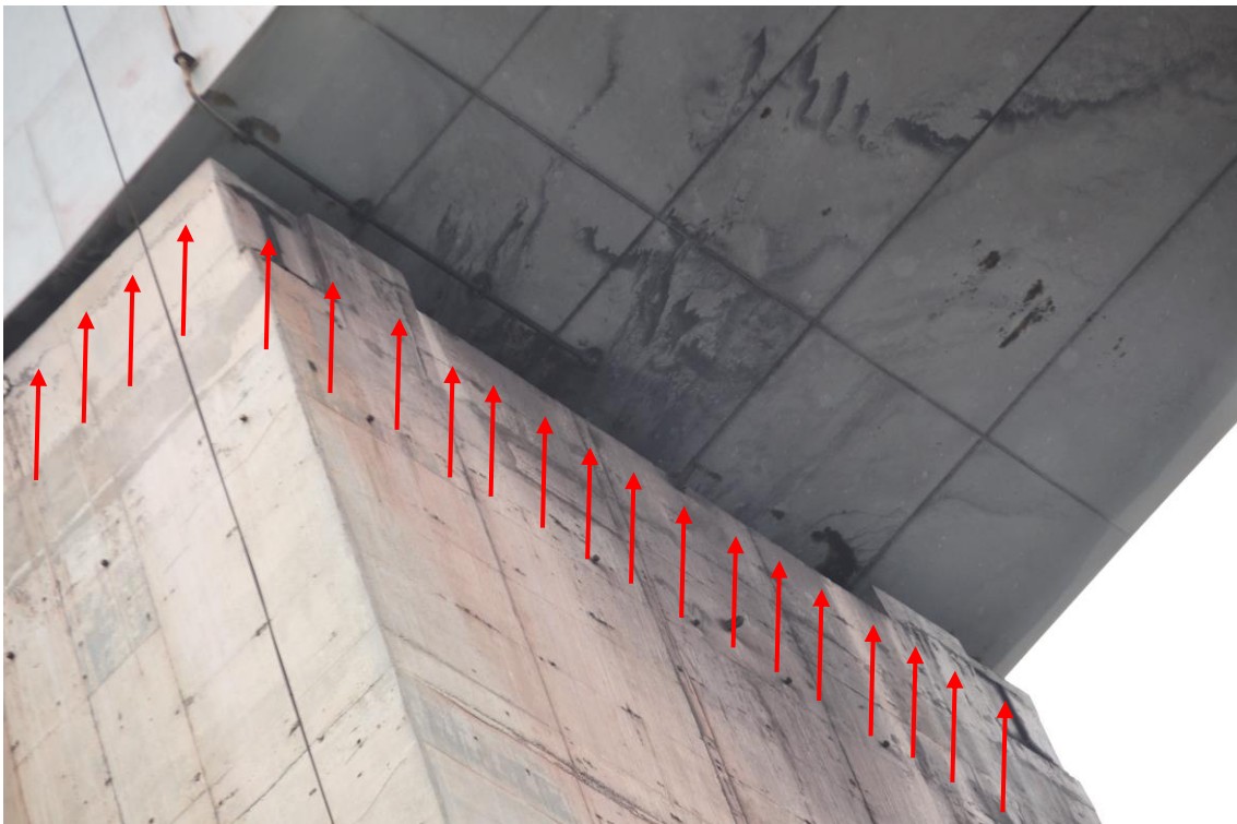
Figura 8 – Apoios do pilar íntegros, indicando sistema de manutenção preventiva regular
