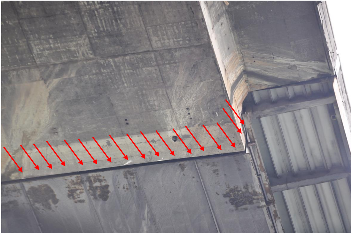
Figura 7 – Junta de dilatação íntegra, indicando sistema de manutenção preventiva regular
