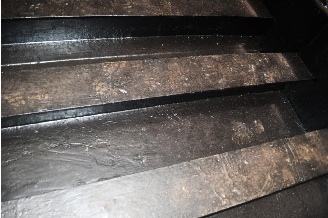
Figura 15 – Aplicação de pintura com alcatrão visando a proteção da estrutura metálica contra corrosão
