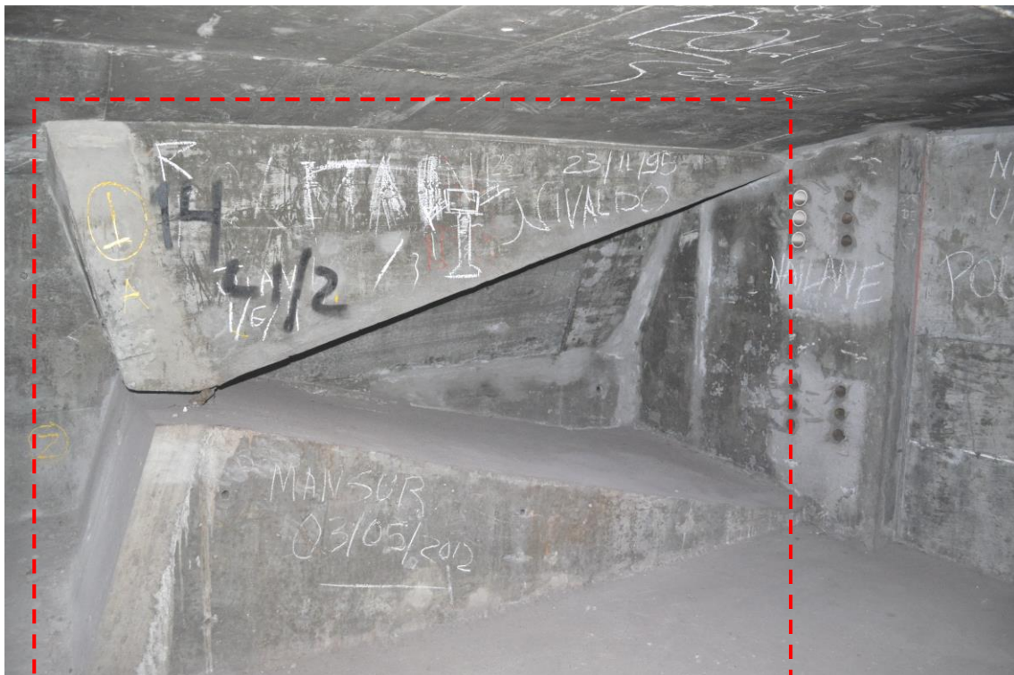
Figura 10 - Blocos de ancoragem das cordoalhas de protensão e caixão de concreto sem indícios de quaisquer anomalias, indicando sistema de manutenção preventiva regular
