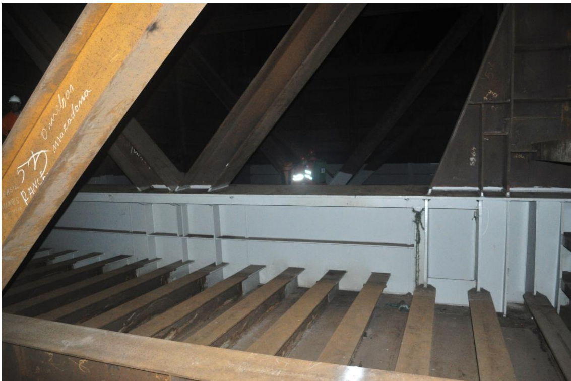
Figura 14 – Vista interna da estrutura metálica do vão central da ponte
