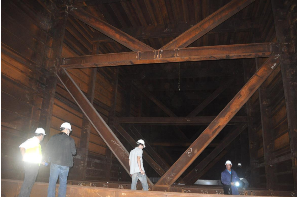
Figura 13 – Vista interna da estrutura metálica do vão central da ponte
